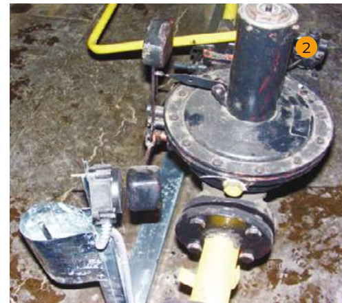
Контроль положения рукояти предохранительно-запорного клапана к контроллеру
