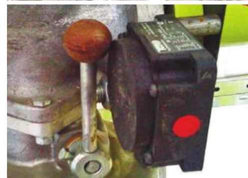
2 Контроль срабатывания предохранительно-запорного клапана индуктивные датчики
